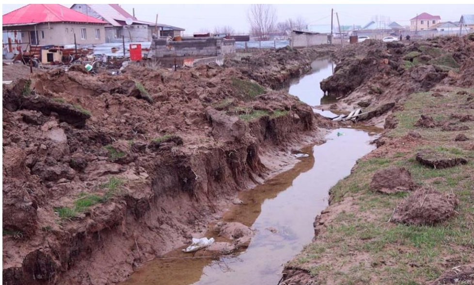
1.2-сурет – Су тасқыны зардабының алдын алу жолдары мақсатында су ағататын құбырларға дейін арықтар жасау
